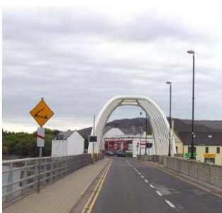
Brücke über den Achille Sound
